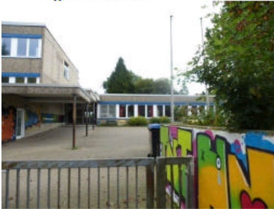
Standort Förderschule ES, Engelbertstraße
